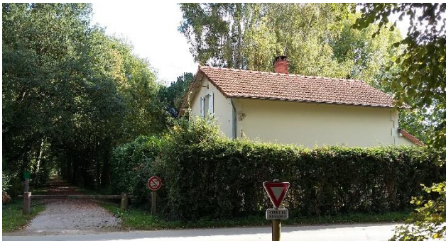
Maisonnette du passage à niveau 77 aujourd'hui. L'ancienne voie de chemin de fer est devenue aujourd'hui
