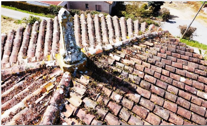
La tour de la Papaudière, détail Cliché T. Bonneau
