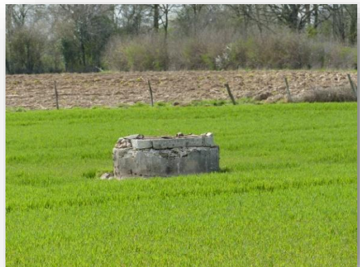
Puits-regard au-dessus d'une tranchée Cliché de l'auteur
